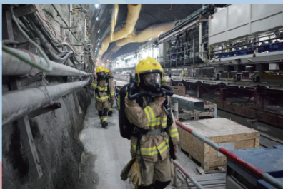
消防人員於隧道內使用閉路式呼吸器進行救援工作。
