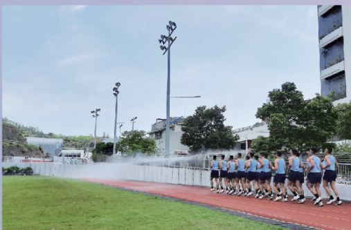
噴霧系統能有效降低運動場跑道的溫度，減低酷熱天氣對屬員的影響。
